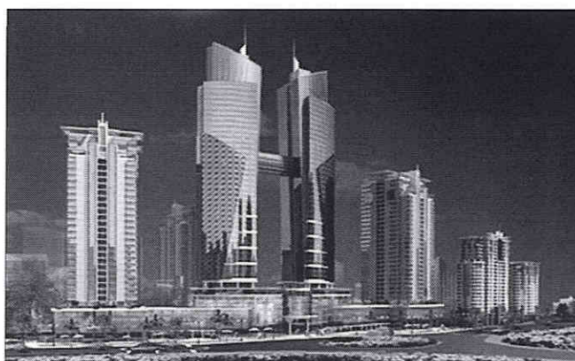
Hình 8: Hình ảnh phối cảnh dự án Khu đô thị Dịch Vọng – Cầu Giấy
